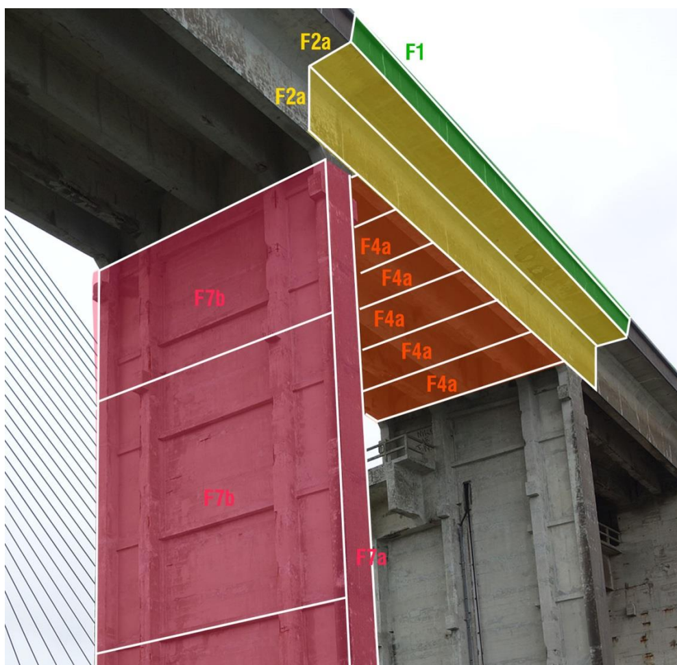
Principe de pose des filets sur le tablier routier et sur piles
